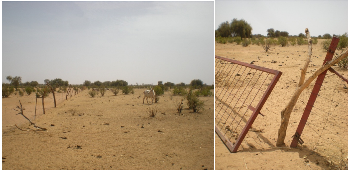
Figure 8 : la MED de Kouel en mauvais état
